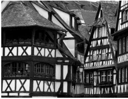
Fig. 1 - The fackwerke system
